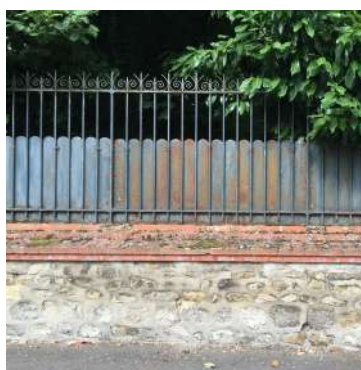
Tôle d'acier brise-vue fixées sur les grilles en ferronnerie, couvrant au maximum 2/3 de leur hauteur.
