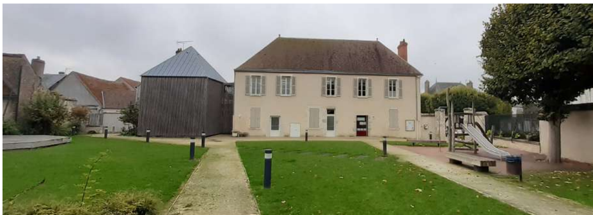
Espace Raymond Chauveau à Boynes (45) Bernard Lavaux arch.
