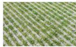
SCADA Rasentiner | Urbastyle urbastyle.com
