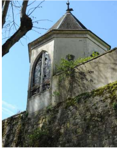
Construction sur le rempart.
