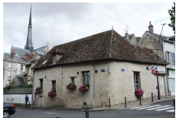
Plusieurs maisons anciennes (avant les XVIIIe siècle) en maçonnerie de pierre se sont maintenues, souvent du fait de leur qualité de construction. Elles constituent un patrimoine de plus en plus rare.
