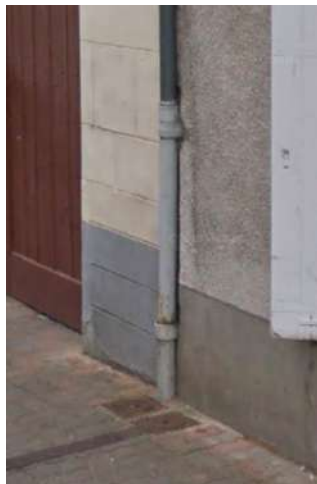
Dauphin en fonte en pied de descente d'eaux pluviales.
