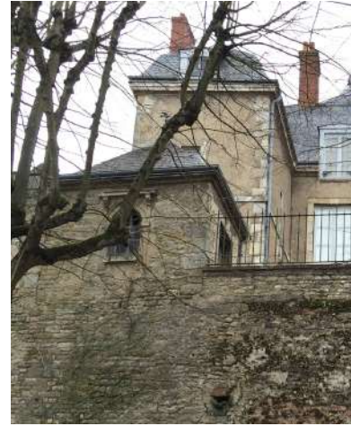
Construction sur le rempart.
