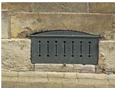
Soupirail en tôle d'acier ajourée.
