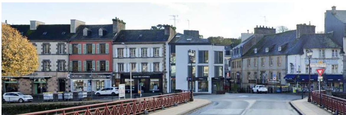
Petit immeuble d'habitation contemporain, avec rez-de-chaussée commercial, inséré en angle de rue principale dans un front bâti patrimonial. Chateaulin (29) - GoogleMaps
