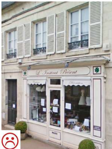
Eviter : les rechapis dans la mise en peinture de la façade ; les stores à festons.
