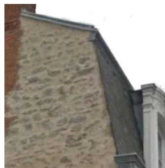
Couverture en ardoise avec deux mises en oeuvre de rive latérale différentes.
