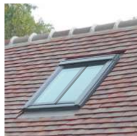
A noter : faitage à crête et embarrure.
