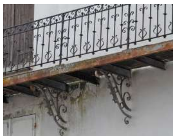
Balcon et consoles en ferronnerie.
