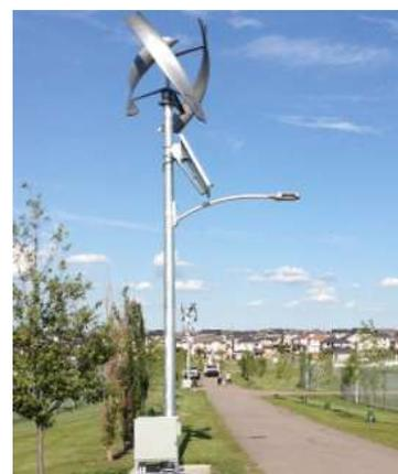
Éolienne à axe vertical, couplée à un panneau photovoltaïque pour l'éclairage public.
