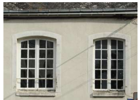
Encadrements de baie en pierre calcaire beige uni, enduit de même couleur.
