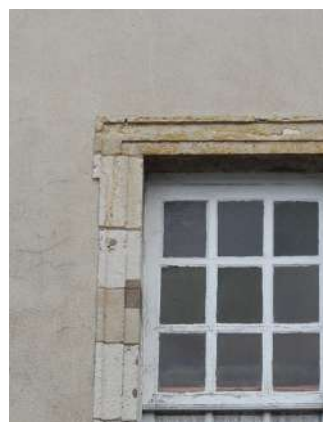
Cadres de baie du château de l'Ardoise en calcaire de Souppes, façade enduite.
