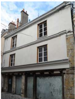
L'encorbellement au-dessus du rez-de-chaussée, et les cadres de baie en bois signalent la structure en pan de bois ; l'immeuble a été recouvert d'un enduit au plâtre gros, avec lequel de larges corniches ont été tirées pour donner à la façade l'esthétique néo-Classique.
