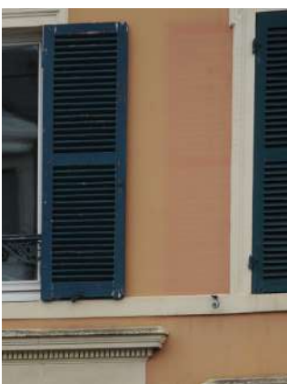
Enduit fortement teinté d'ocre ; les couleurs soutenues évoluent différemment selon l'exposition à la lumière (trace des volets).
