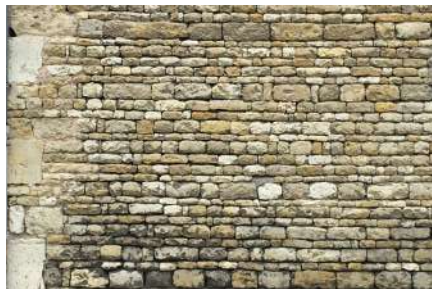
Maçonnerie de moellons calcaire à lits d'épaisseurs différentes, sans jointoiment, avec chaînage d'angle en pierre calcaire.
