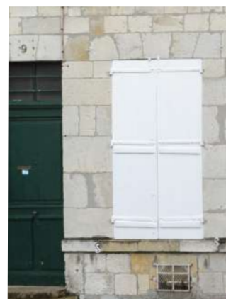
Façade en pierre de taille mise en œuvre en lits de différentes hauteurs.
