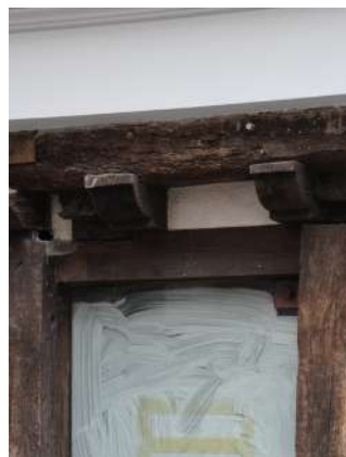
L'encorbellement au-dessus du rez-de-chaussée, et les cadres de baie en bois signalent la structure en pan de bois ; l'immeuble a été recouvert d'un enduit au plâtre gros, avec lequel de larges corniches ont été tirées pour donner à la façade l'esthétique néo-Classique.
