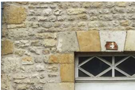
Maçonnerie de moellons calcaire à joints beurrés.
