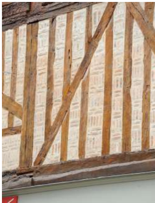
Pan de bois apparent à remplissage de brique au nu de la structure, destiné à rester apparent.
