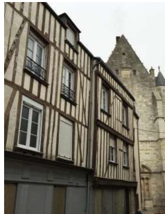
Pan de bois apparent à remplissage (hourdage) enduit.
