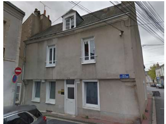
Pan de bois masqué par un enduit, perceptible par la structure en encorbellement au-dessus du rez-de-chaussée.
