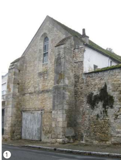
1 Vestiges de l'église Saint-Jean Rue du Parc.
