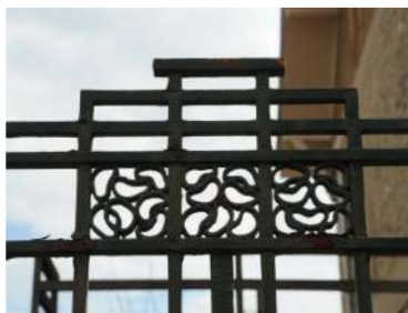
Mur-bahut et grille en acier peint. Une solution ancienne (XVIII e siècle) qui permet de choisir entre voir le bâti ou préserver l'intimité du jardin avec végétation ou dispositifs d'occultation.
