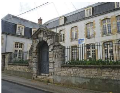
Mur-bahut et grille en acier peint. Une solution ancienne (XVIII e siècle) qui permet de choisir entre voir le bâti ou préserver l'intimité du jardin avec végétation ou dispositifs d'occultation.
