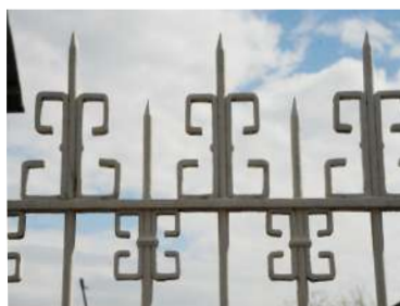
Mur-bahut et grille en acier peint. Une solution ancienne (XVIII e siècle) qui permet de choisir entre voir le bâti ou préserver l'intimité du jardin avec végétation ou dispositifs d'occultation.
