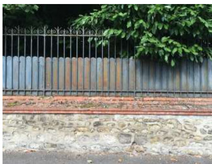
Mur-bahut et grille en acier peint. Une solution ancienne (XVIII e siècle) qui permet de choisir entre voir le bâti ou préserver l'intimité du jardin avec végétation ou dispositifs d'occultation.
