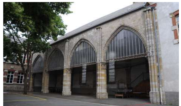
Ancien bas-côté de l'Eglise collégiale St-Georges du XIIIème siècle, conservé et transformé en préau pour l'école en 1900. Carte postale 1902, Archives municipales, et état actuel.
